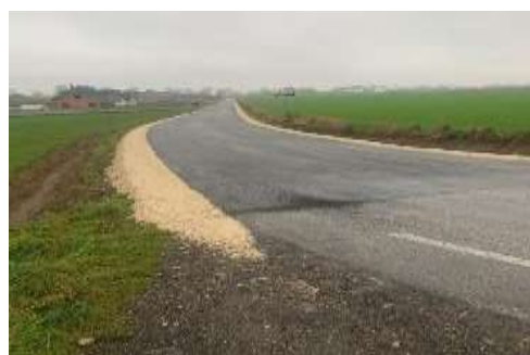
Wyremontowana droga gminna w Konradowie
