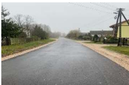
Wyremontowana droga gminna w Kuźnicy
