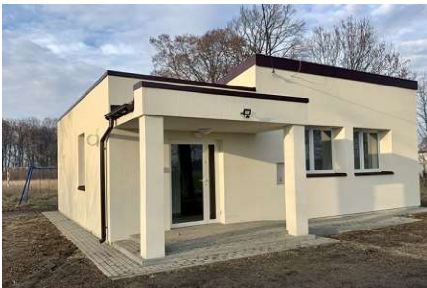
Świetlica w miejscowości Feliksów
