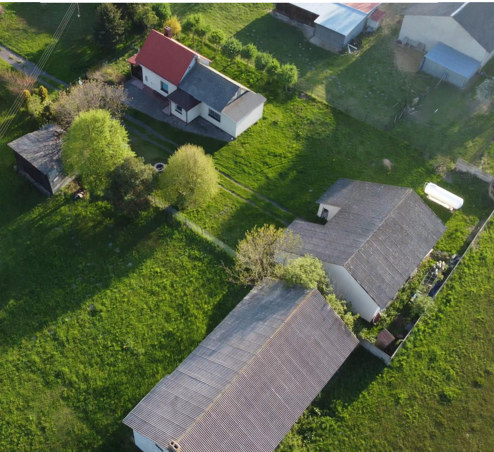
Fot. 1. Wykorzystanie wyrobów azbestowych jako pokrycia dachowe.
